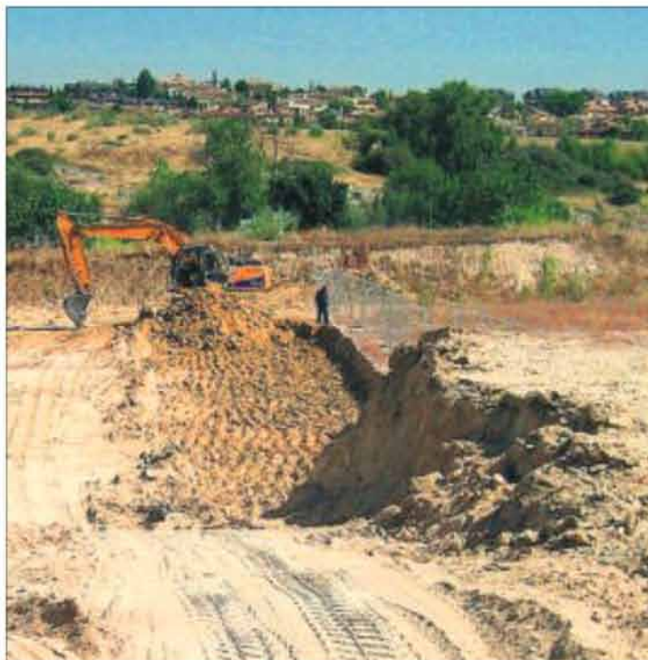
Este lunes han empezado las obras de edificación en Valdebebas.
